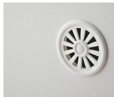
Wywietrzniki w szafkach dolnych.
