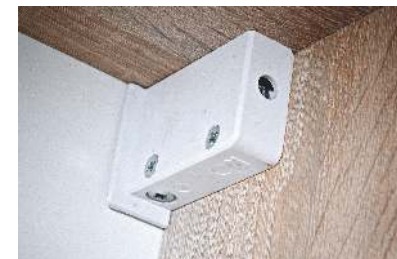
Zawieszki regulowane w szafkach wiszących. Adjustable hangers in wall cabinets.
